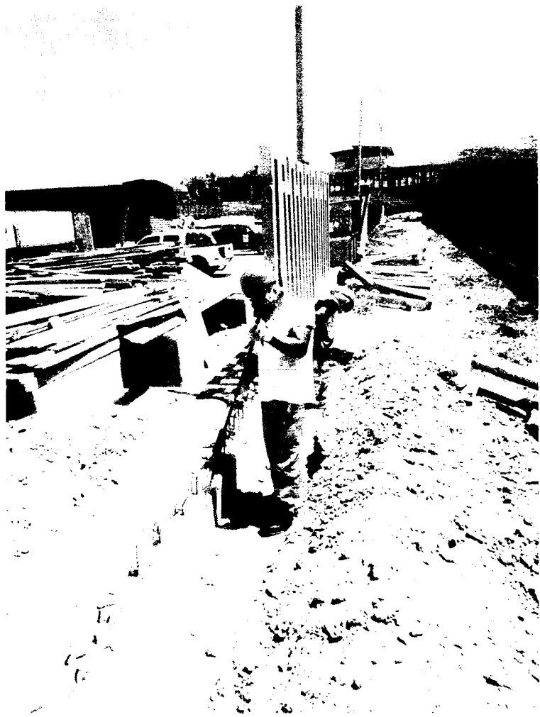
DEMOLICION DE CERCO PERIMETRICO INC. SOBRECIMIENTO
